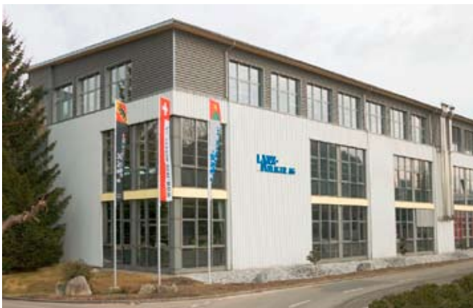
Firmengebäude mit neuem Obergeschoss (nach Minergiestandard).
